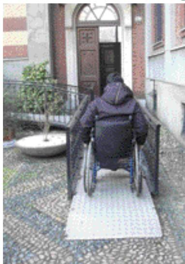
La chiesa è accessibile tramite una rampa lunga 9.10 m e larga 1 m che permette di superare un dislivello di 1.02 m (sette gradini, uno da 12 cm e altri sei da 15 cm), pendenza circa 11%.
