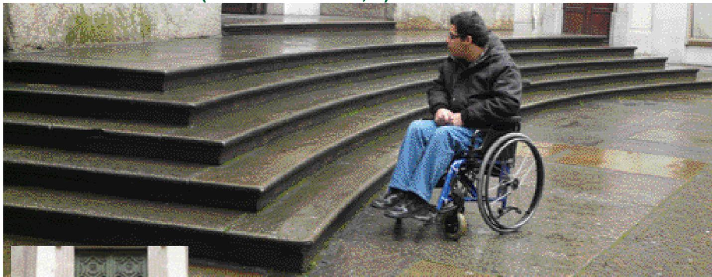
Inaccessibile, in quanto davanti all'ingresso unico ci sono sei gradini (cinque da 16.5 cm più uno da 14.5). La chiesa è preceduta da un vasto sagrato che permetterebbe di inserire una rampa, anche fissa: lateralmente alla scalinata sarebbero utilizzabili 4.30 m. Al momento del sopralluogo, la chiesa era chiusa.
